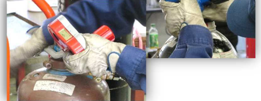
酸素とアセチレンの混合ガスを使います。
